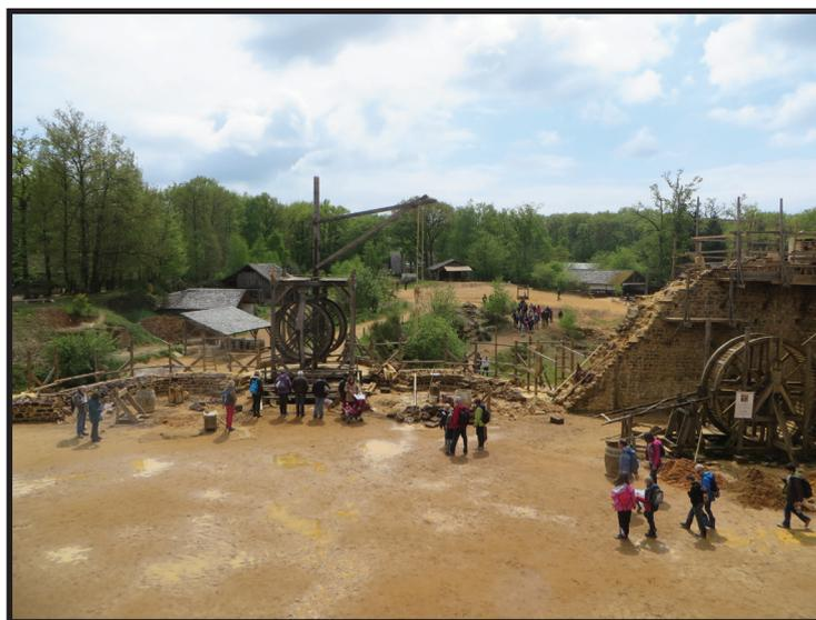
Pour monter les pierres en haut du château, on utilise la cage à écureuil : c'est une grande roue à l'intérieur de laquelle un ou deux ouvriers marchent rapidement ; la roue tourne et le plateau avec les pierres s'élève.
